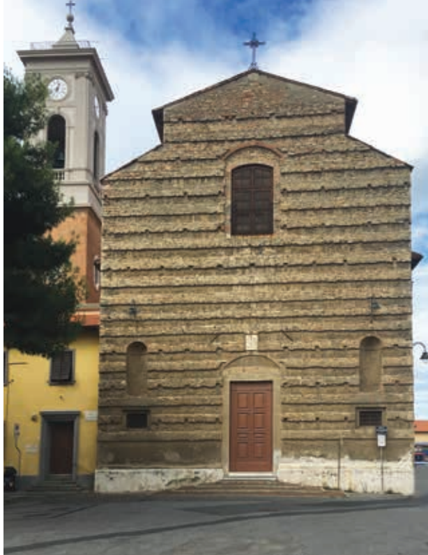
The Church of San Ferdinando Re in Piazza del Luogo Pio
